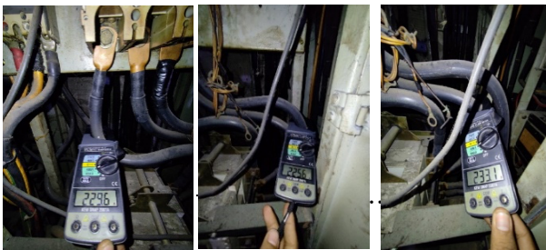
Gambar 2 Pengukuran arus pada panel SDP
